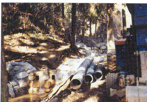
V rekonstrukcijo Farskega potoka smo vlagali skupaj z državo, dela pa je izvajalo podjetje za urejanje hudournikov iz Ljubljane. Zaradi izgradnje pregrad se bo zmanjšala erozijska moč potoka ter nanos naplavin v spodnjem toku.
