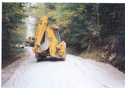
Na cesti Šentanel 1. faza: križišče Sp. Jamnica Kolman smo zaključili dela na spodnjem ustroju ceste. Zaradi boljše kvalitete izvedenih del bomo asfalt polagali v pomladi 2002.
