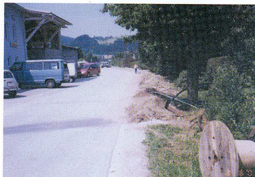
Izgradnja javne razsvetljave na cesti Ob Meži v dolžini 1 km
