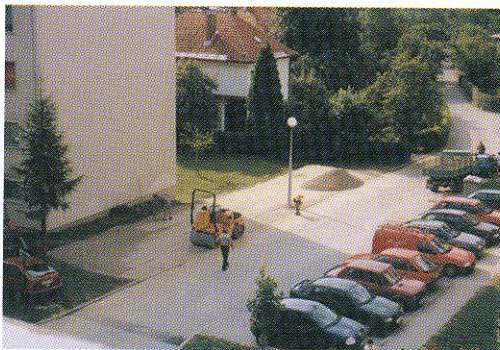
Izgradnja parkirišča med Trgom 3 in 8-12 parkirnih mest
