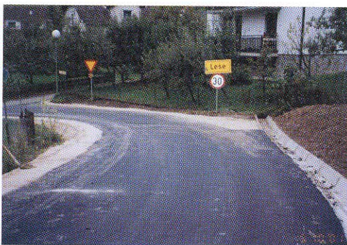
Asfaltiranje cestnega odseka v dolžini cca 100 m na Lešah
