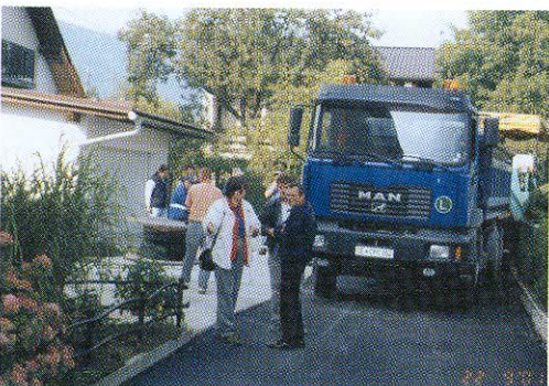
Del Sp. kraja - J od Flajmiza je dobil novo podobo: izvedli smo asfaltiranje cestnega odseka ter dveh ulic, zamenjali kanalizacijo, vodovod, položili kabel za CATV in telefon. (vrednost opravljenih del je znašala okoli 20 mio SIT)
